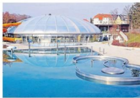
Das Schwimmbecken im Freiberg Johannisbad ist schon mit Wasser befüllt.
